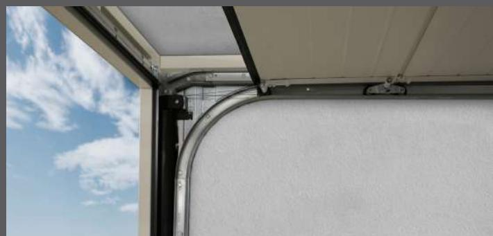
Dettaglio guida laterale di scorrimento
